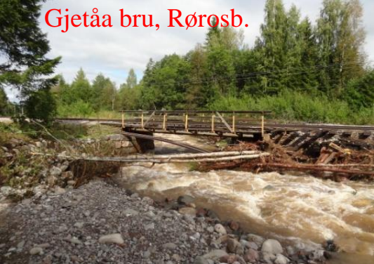
Gjetåa bru, Rørosb.
