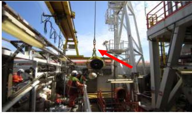
Løftet er overført til kran 2, talje og traverskran kobles ifra
