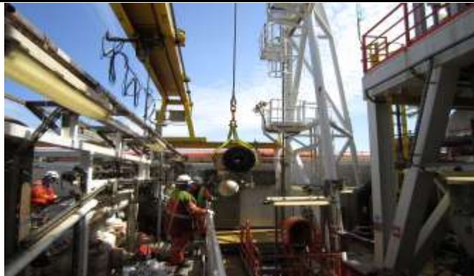
Løftet er overført til kran 2, talje og traverskran kobles ifra
