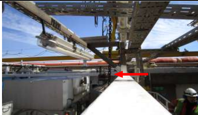
Kjetting til traverskran går ned akter om bjelken.
