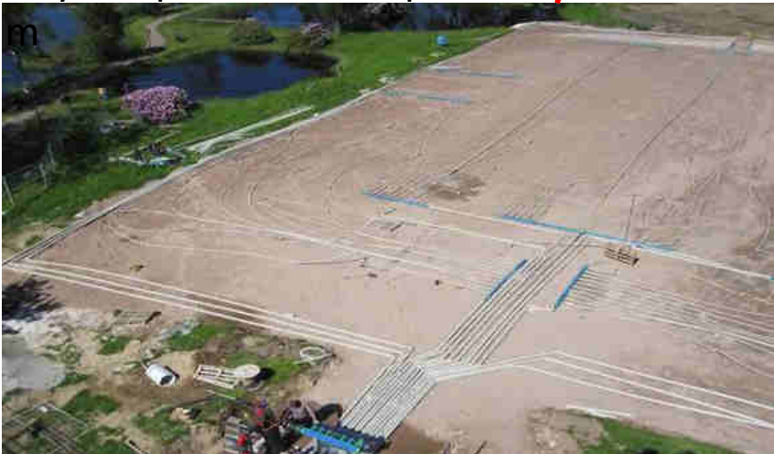
Høy temperatur brønnpark 140/brønner a 150 m
